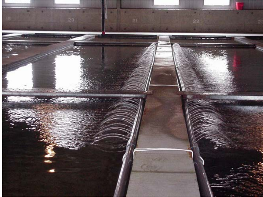
Рис. 61. Аэрация питомных каналов в период кормления молоди, Охотский ЛРЗ
